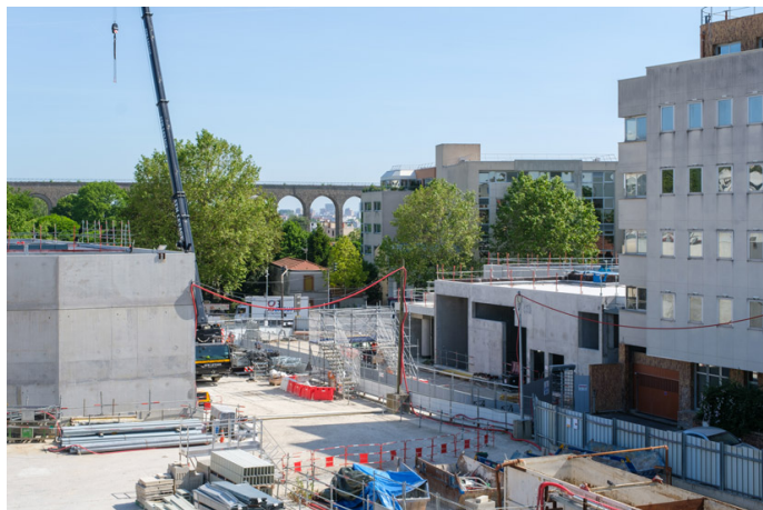
La gare Arcueil-Cachan pendant les travaux (2023). Crédit : Muriella Romaniello
