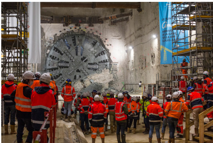
L'arrivée du tunnelier Amandine à Cachan (2020). Crédit : D. Delaporte
