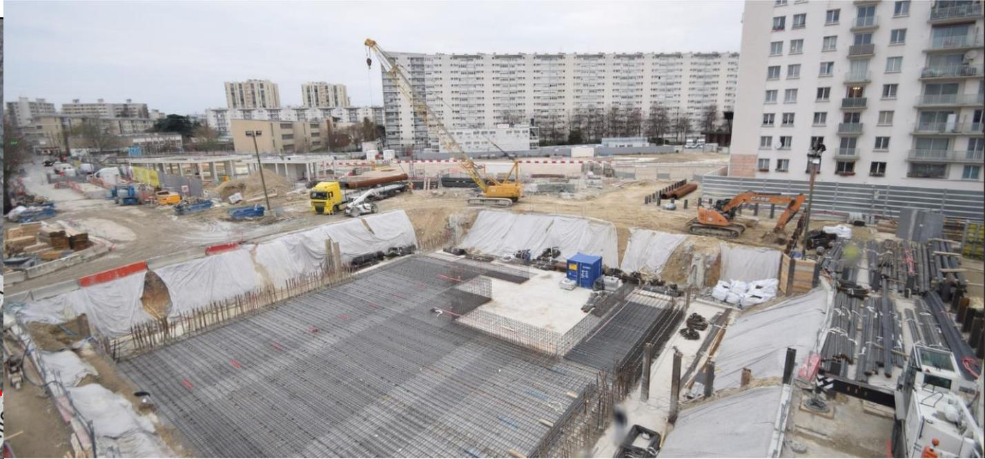
Gare de Bagneux : réalisation de la dalle de couverture et préparation pour le passage du tunnelier prévu fin 1<sup>er</sup> trimestre 2019
