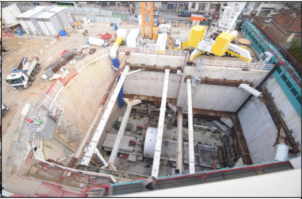
Gare d'Arcueil Cachan : travaux de parois moulées sous les voies du RER B et montage du tunnelier en cours.
