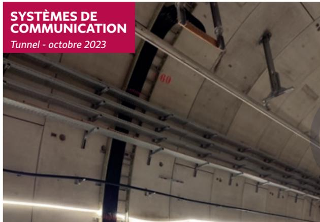
Cette étape consiste à installer l'ensemble des équipements de télécommunication, fibre optique et réseau mobile au sein des gares et ouvrages, sans oublier le tunnel dont les premiers câbles radio sont en cours de déploiement entre la gare Champigny Centre et le Centre d'Exploitation de Champigny-sur-Marne.
