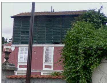
Cette construction en moellon enduit de couleur rouge est recouverte de tuiles mécaniques. Elle possède un étage surmonté d'un haut grenier en pan de bois fermé par des persiennes qui servait de séchoir. Le bâtiment est recouvert d'un toit à longs pans.
