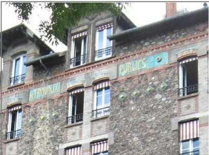
Le bâtiment de l'ESTP est construit en meulière avec des cloisons horizontales en béton armé et la toiture est recouverte de tuiles plates. La façade présente de nombreux motifs de couleurs.
