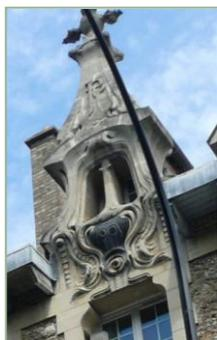
Les rez-de-chaussée et lucarnes sont en calcaire et les étages en meulière. La façade présente des encadrements de baies en calcaire et des toits à longs pans et pignons découverts.
