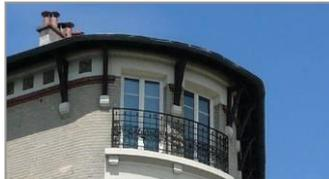
Cet immeuble présente une architecture caractéristique du début du XX<sup>ème</sup> siècle : toit à longs pans recouverts de tuiles mécaniques, pierres de taille en rez-de-chaussée, brique enduite, corniche en brique, modénature soulignant le débord de toit, garde-corps en fer forgé.
